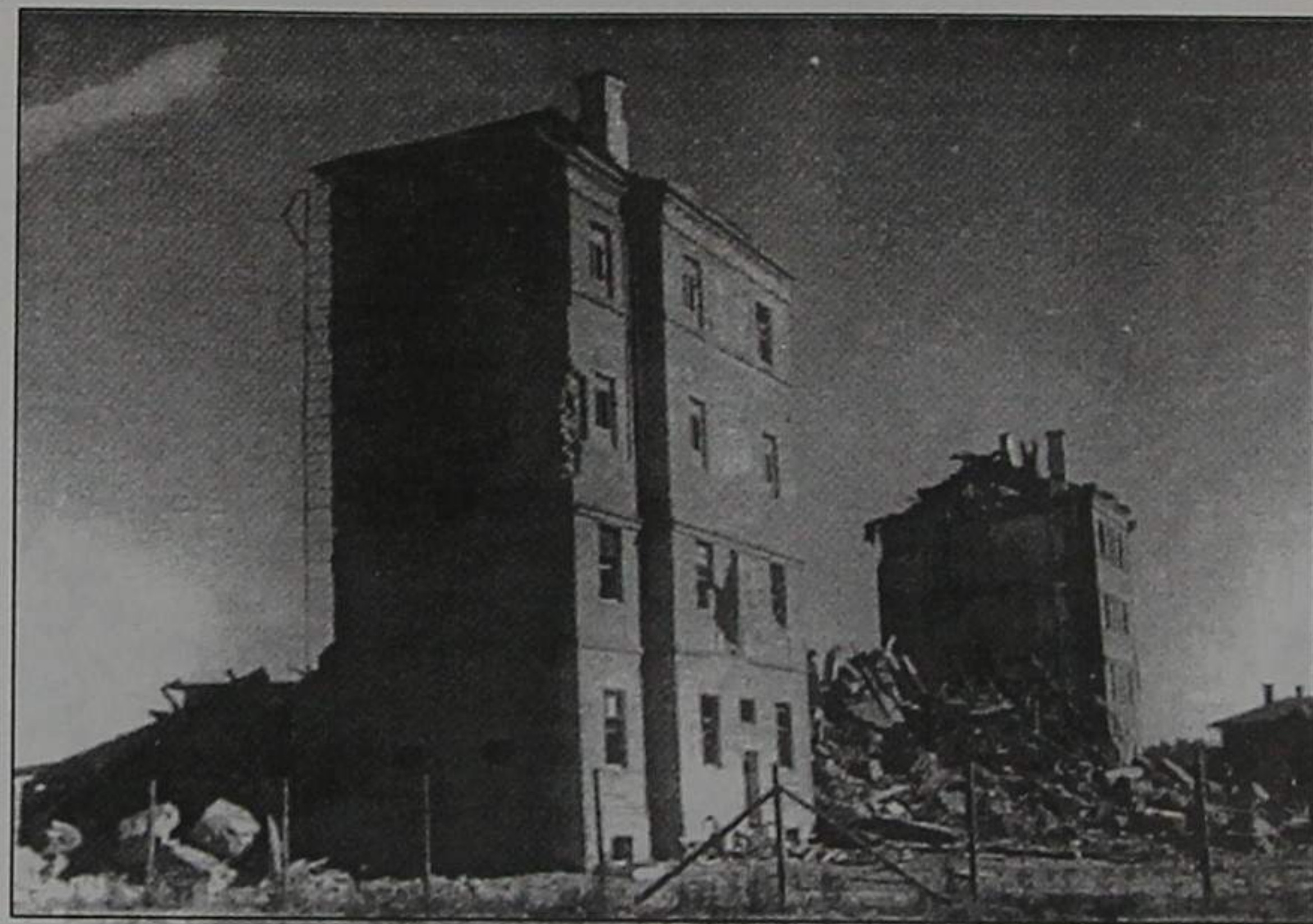
Город Ярцево. Разрушенные жилые дома
