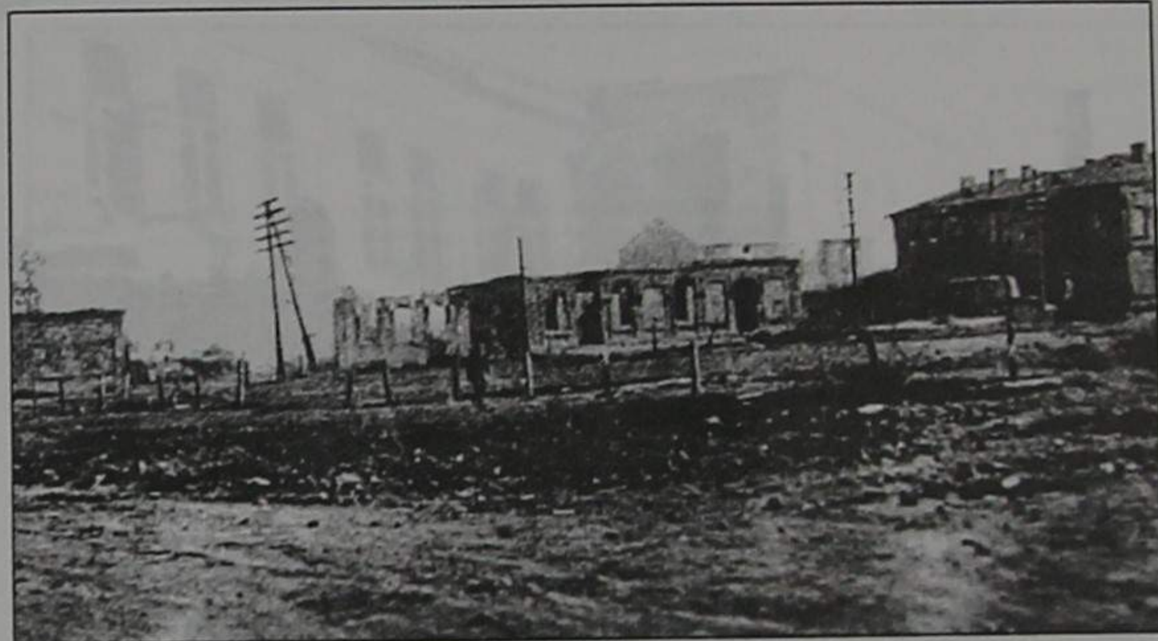
Разрушенные здания в г. Ельне
